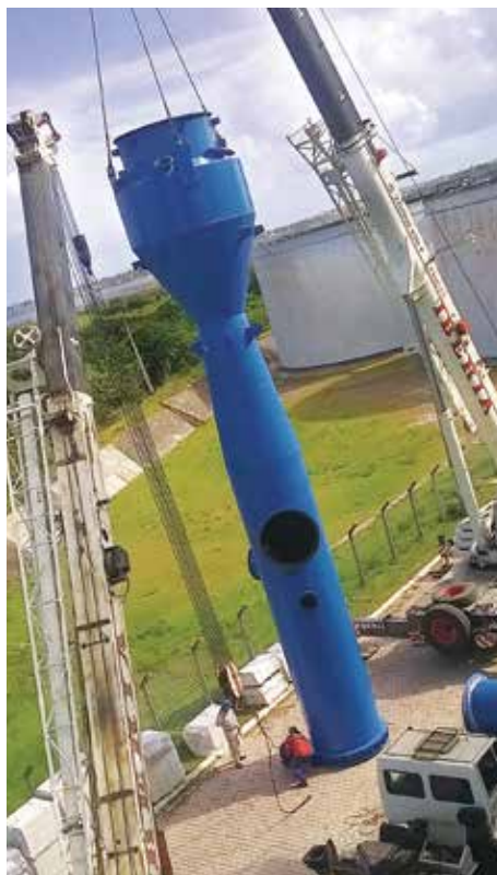
Torre Venturi, de 17 metros de altura, especializada no tratamento de gases originados da produção
