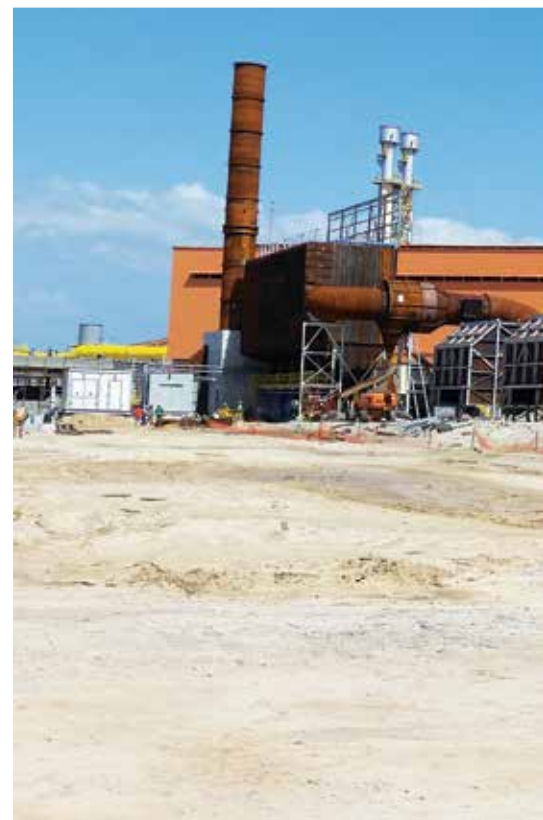
Construção da DRIOX para a CSP
