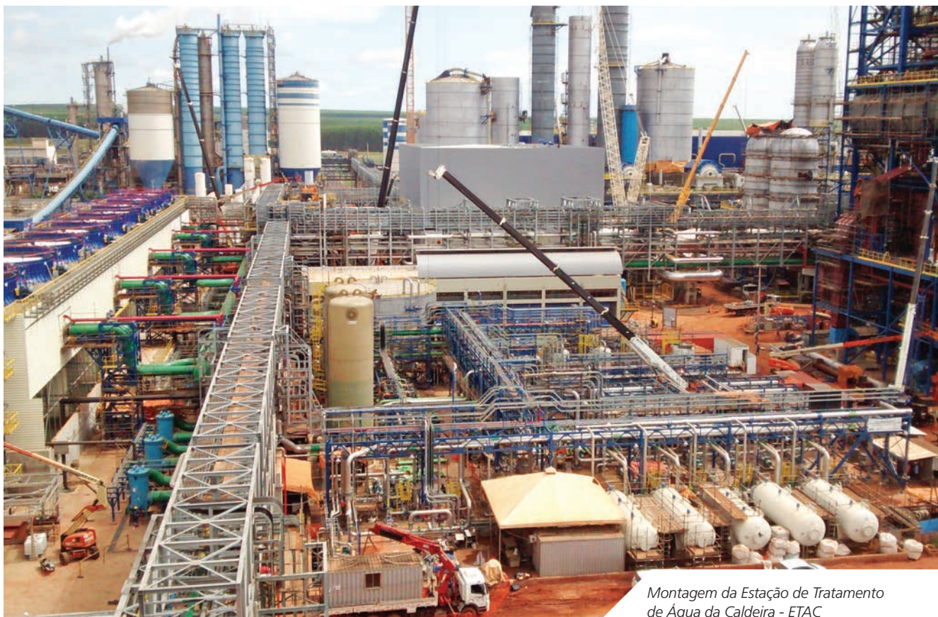
Montagem da Torre de Resfriamento
