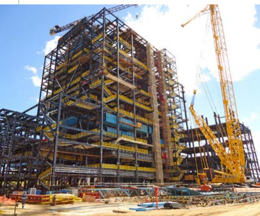
Estrutura metálica da caldeira e do prédio da turbina totalizam 7.400 toneladas
