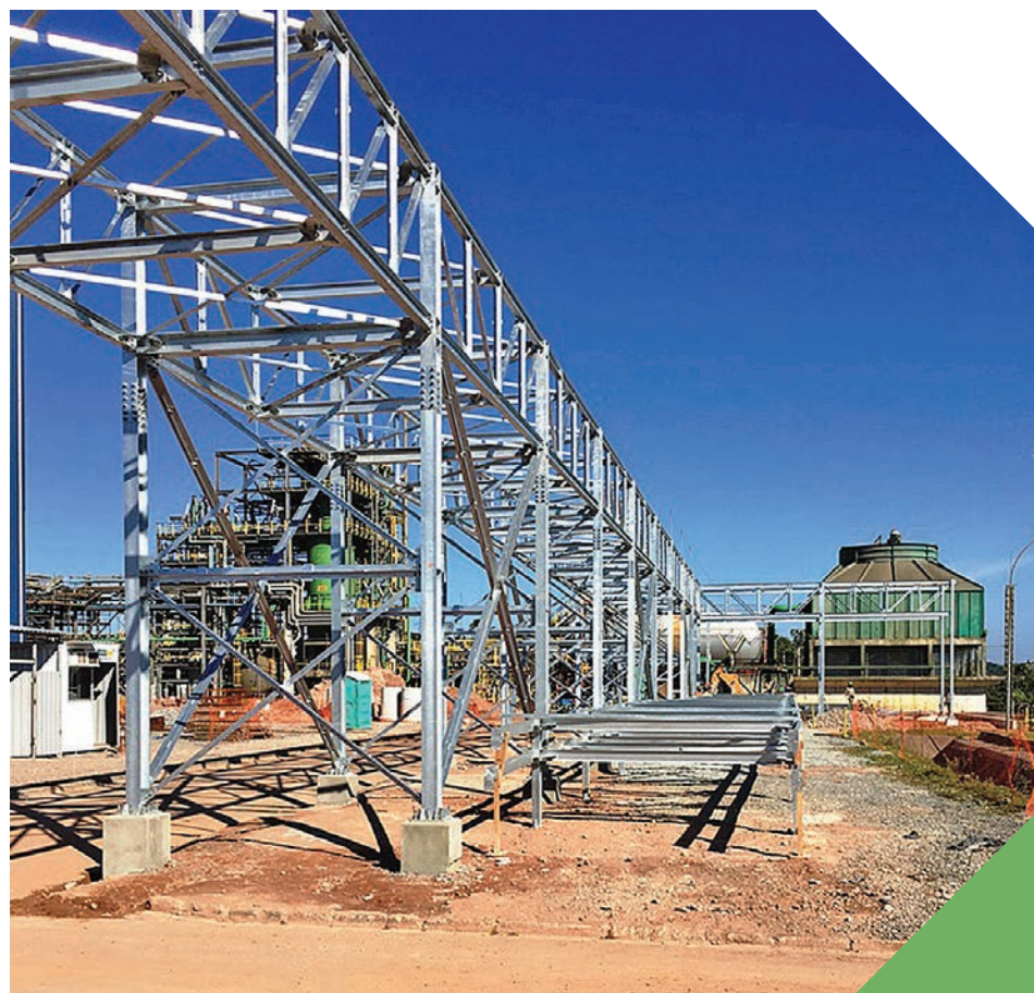
Projeto engloba a montagem de equipamentos e tubulações
