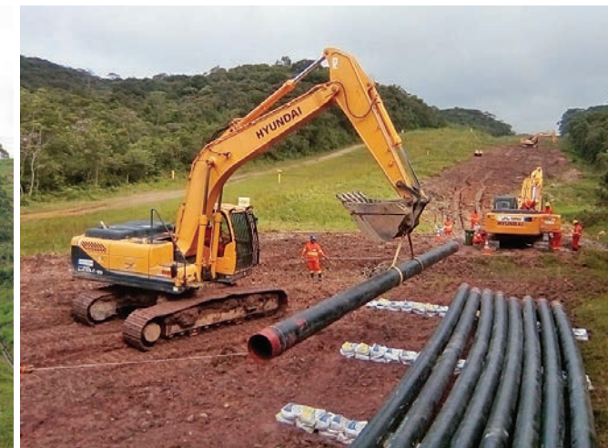
900 colaboradores no pico de mão de obra são os responsáveis por montar mais de 90 quilômetros de dutos
