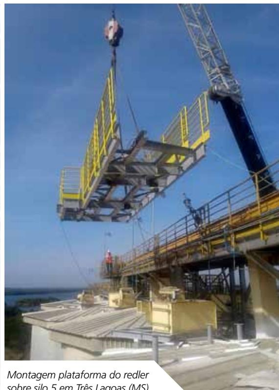
Montagem plataforma do redler sobre silo 5 em Três Lagoas (MS)
