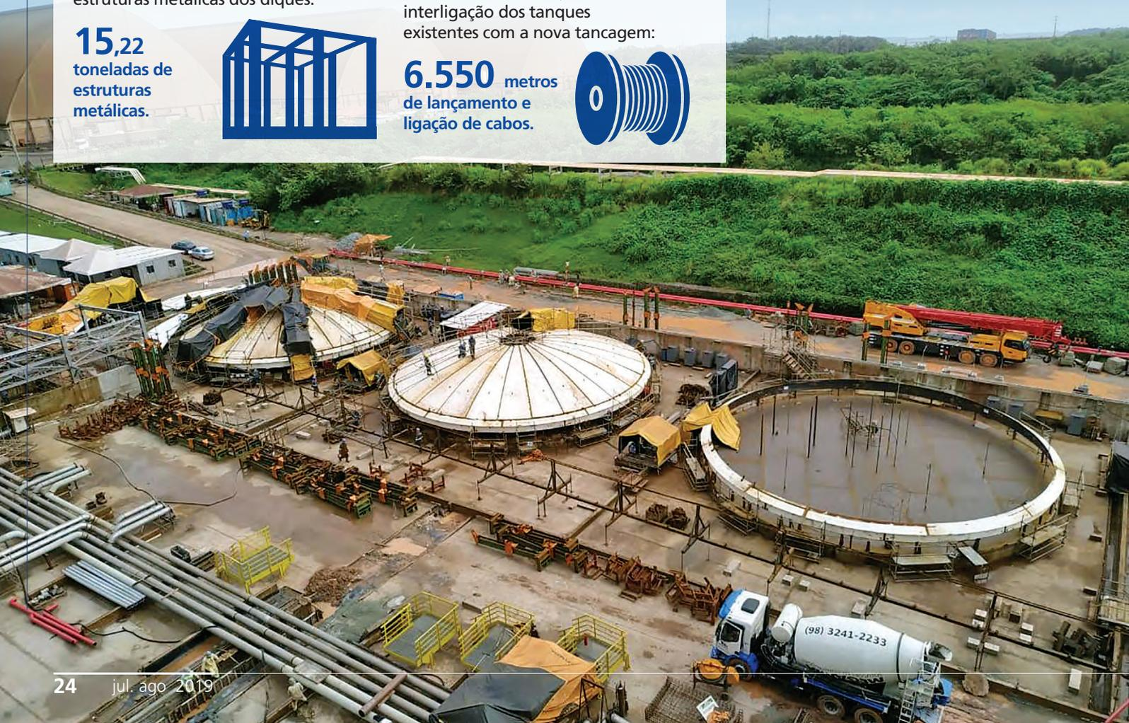
TQ-28, TQ-29 e TQ-30. Os tanques têm 6.000m<sup>3</sup> cada, com 19,09m de largura, 23m de altura e 180 toneladas.
